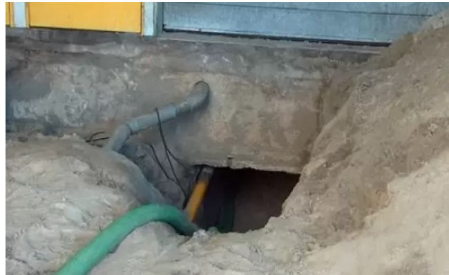
Luchtkanalen onder fundering
